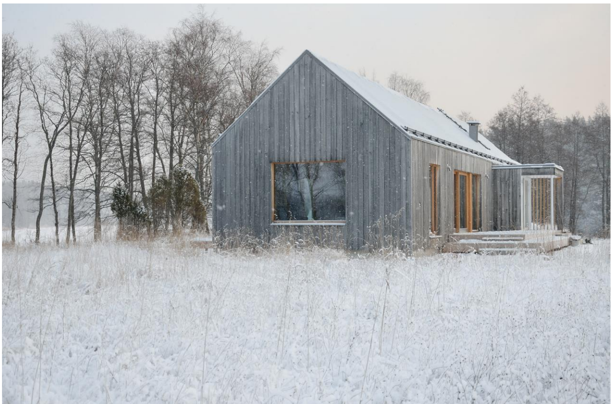
Afbeelding 5: Referentiebeeld architectuur in de vorm van een boerenschuur.
