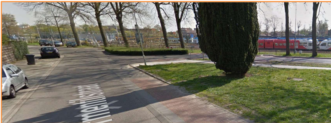
Fig. 7. De kruising Tormentilstraat - Noordelijke Parallelweg is gevaarlijk, omdat fietsers met hoge snelheid de Tormentilstraat afdalen, en er vaak van rechts een treintje van doorgaand verkeer nadert, dat vooral naar rechts kijkt. Gelet op de eenrichtingssituatie en het prioriteren van de fiets is een voorrangskruising hier zeer gewenst.
